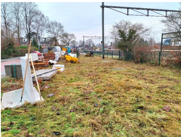
Links: Perceel 4 met opslag van materiaal..
